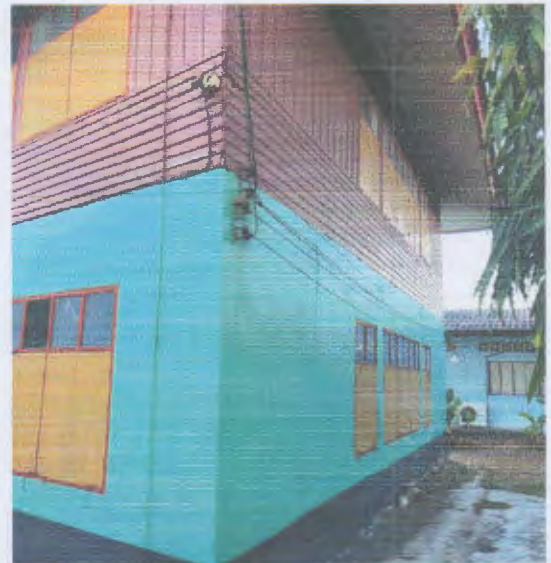
ด้านข้างอาคาร (ฝั่งขวา)
